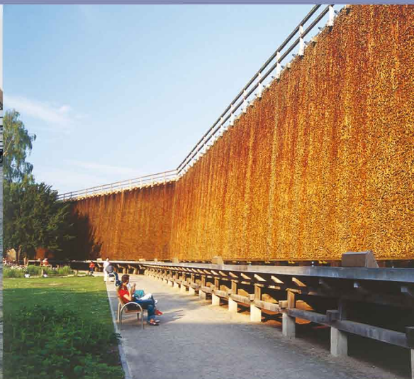
Tief einatmen! - An einem der Gradierwerke
