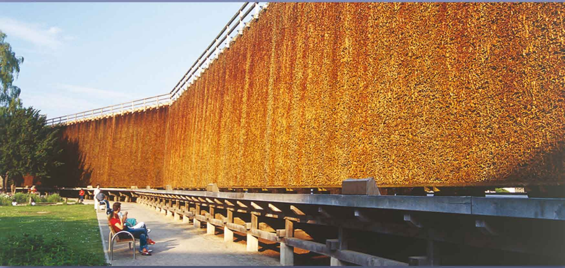
Das Gradierwerk erzeugt salzhaltige Luft
